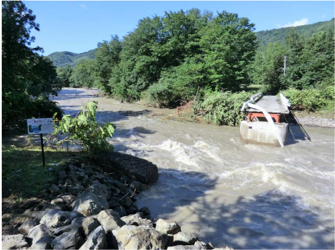
写真-2 右岸より上流側
