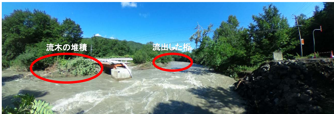
写真-1 現場全体状況（右：右岸、左：左岸）
