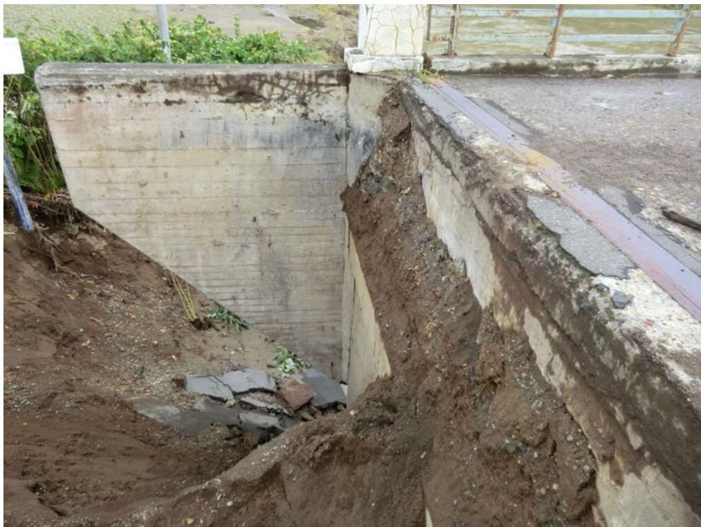
写真-4 左岸橋台下流側ウイング
