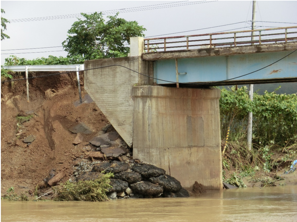
写真-3 左岸橋台（上流側）
