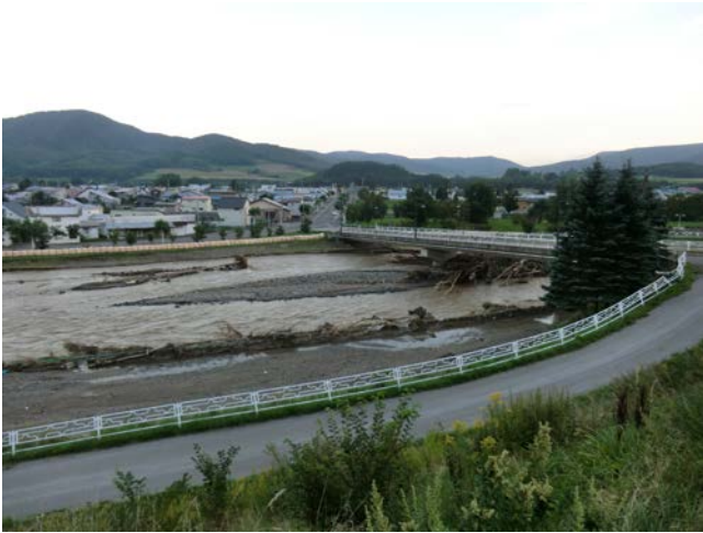
写真-11 左岸下流側からの俯瞰
