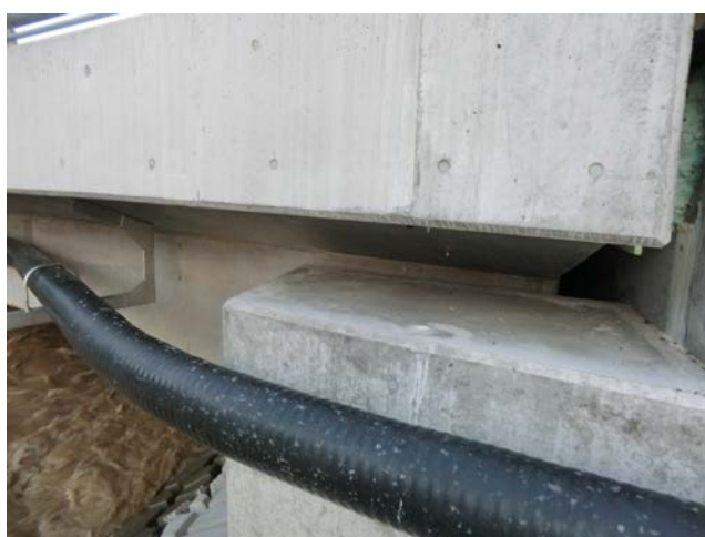
写真-10 橋台の横変位拘束構造
