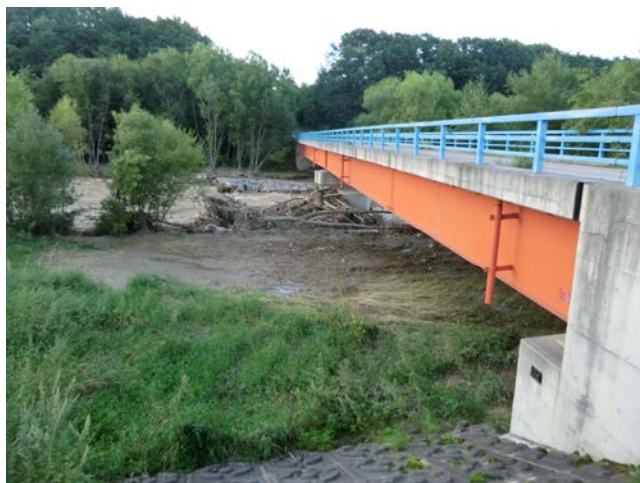
写真-2 上流側全景
