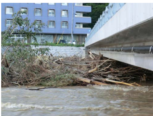
写真-9 主桁への接触（上流側）
