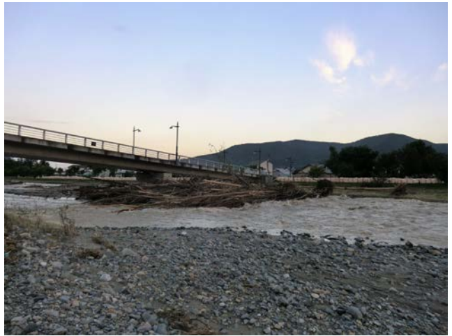
写真-12 P1 橋脚への流木堆積①
