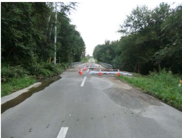
写真-5 右岸 (A2) から左岸 (A1) を望む
