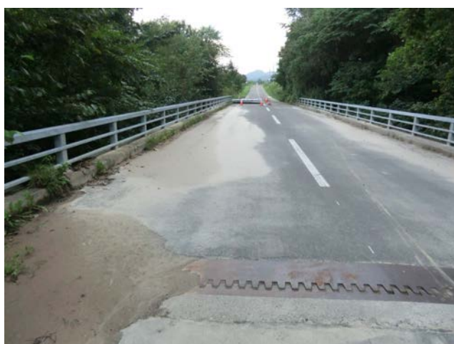
写真-2 左岸（A1）から右岸側（A2）を望む
