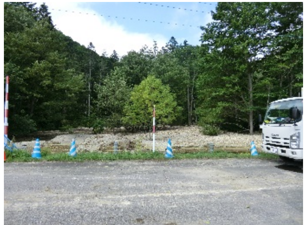
図2 土砂堆積箇所
