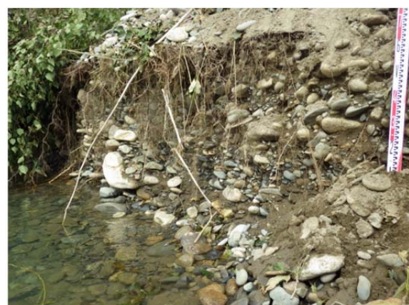
図3 堤体下部の地盤状況
