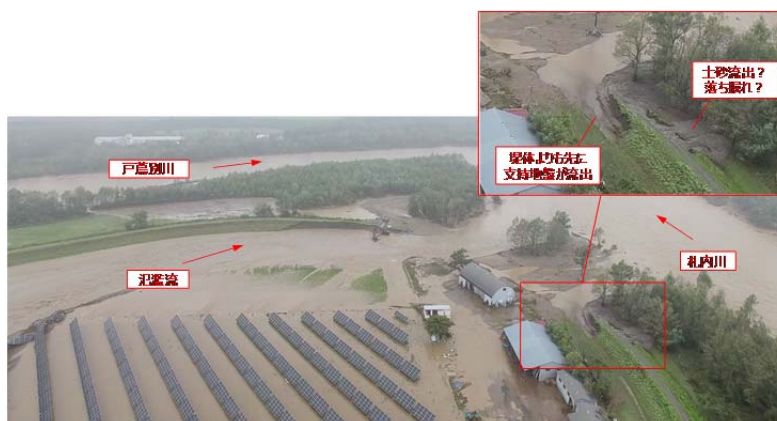
図1 破堤箇所の状況 (帯広開発建設部提供資料に加筆)
