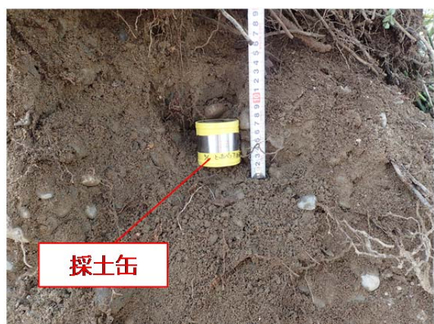
図4 上流方破堤断面でのサンプリング状況
