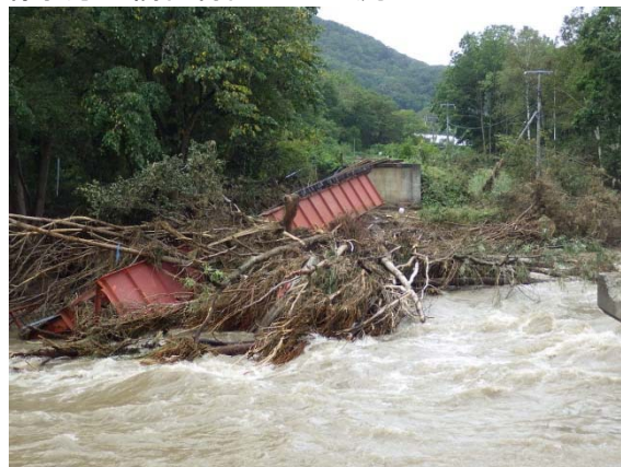
図2 流木の堆積状況
