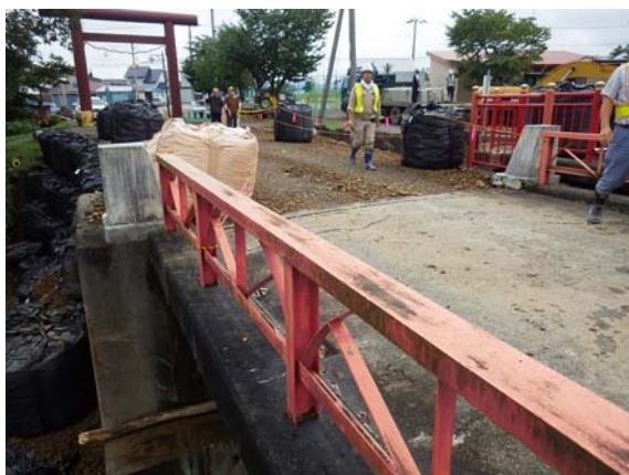
図1 右岸側橋台の応急復旧状況
