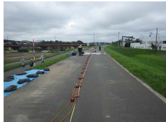
図4 地盤調査の実施状況
