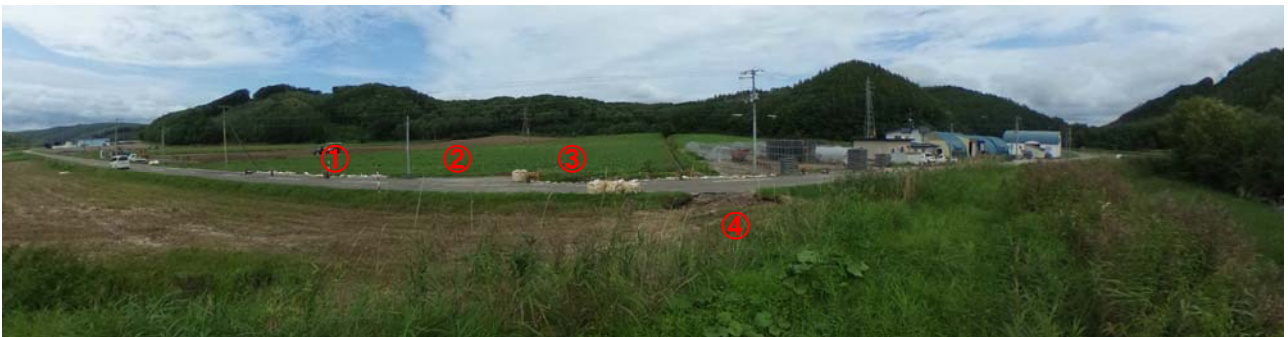
図1 被災箇所全景（訓子府川堤防から撮影）
